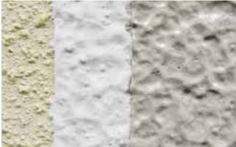
既存塗膜（リシン面） ダイヤアクリスフィラー（多孔質ローラー） ダイヤニューデポールR（さざなみ模様）
