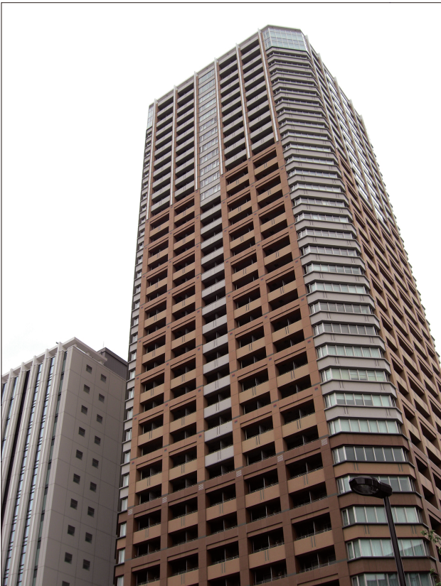
▲施工例：飯田橋プレーン 使用材料：ダイヤアクレスフィラー、ダイヤハイパーシリコンR
