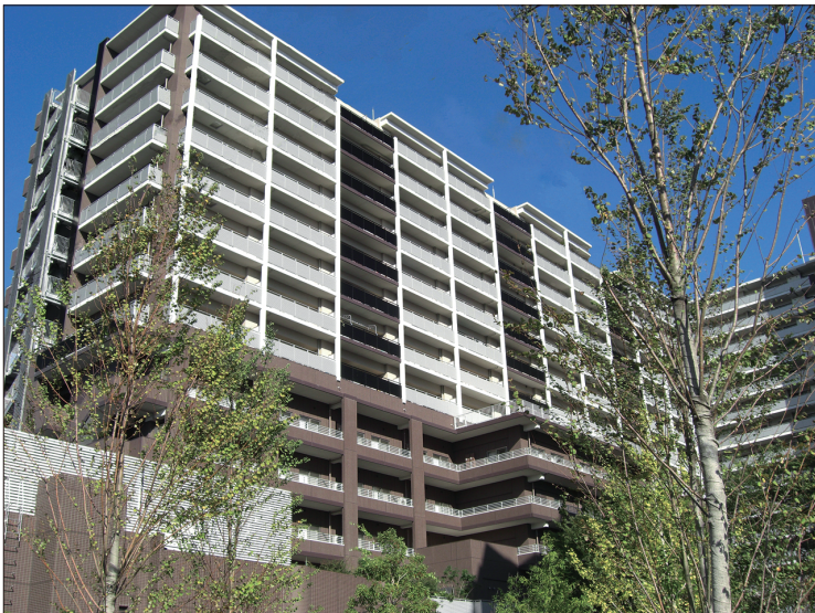
▲施工例：亀戸レジデンス 使用材料：ダイヤニューデポールR
