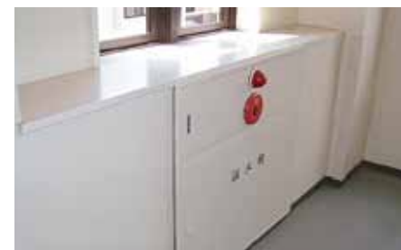
■消火栓ボックス
