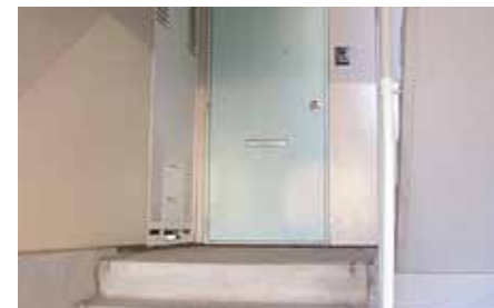
■鉄扉・枠 (住宅扉・PS扉)
